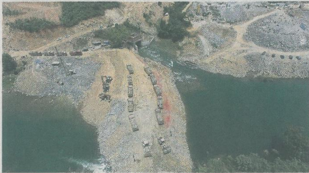
5月18日,《左右江革命老区振兴规划》中重点能源建设项目瓦村水电站工程截流成功。该项目位于广西田林县境内,总投资25亿元,以发电为主,兼顾供水、防洪、航运等综合利用。图为工程截流施工现场。 韦万忠摄(新华社发)
